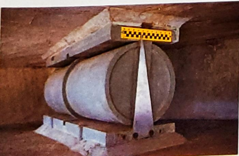
3 Brücke auf Rollen
